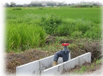
新設吐出口(上八ツ林地内)
